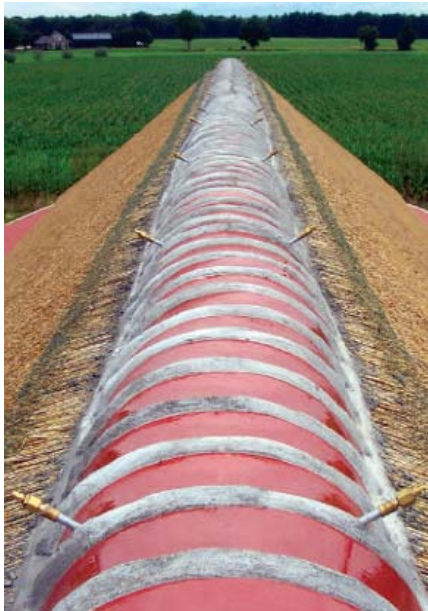
Kuva . Suuttimia tasavälein pitkin harjaa.
