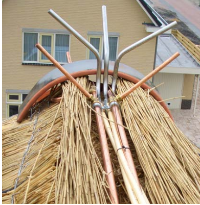
Kuva . Kuivanousuputkisto tulevan harjan alla.
